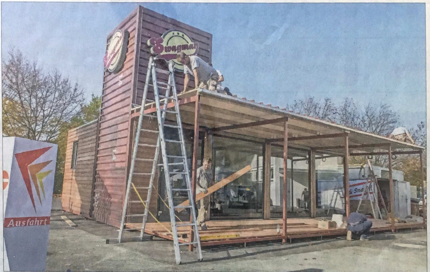
Die Bauarbeiten für das erste Swagman Roadhouse in Bayreuth haben gestern begonnen.
